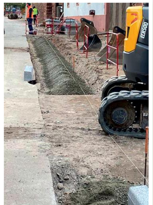
Enfouissement des réseaux secs et mise en place des bordures de trottoir.
